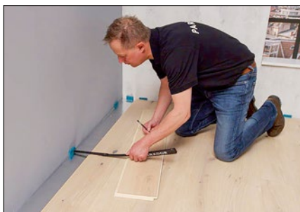
Rapportez le tracé du mur sur la dernière rangée de lames à l'aide d'une chute de lame ou du MultiTool Parador.
