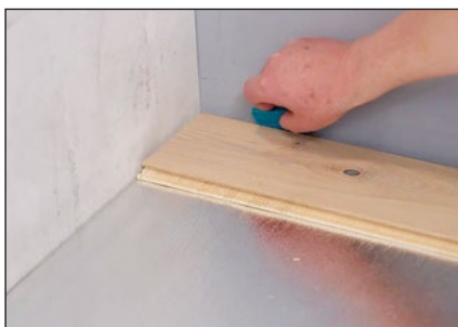
Disposez la surface à poser, mettez-la d'équerre, puis adaptez la première rangée de lames en la découpant aux mesures.
