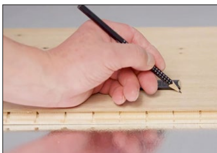
Raccourcissez la dernière lame de la première rangée en respectant l'écart par rapport au mur. Le reste de la lame est utilisé pour commencer la deuxième rangée.
