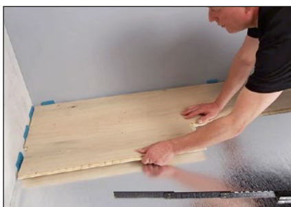
Débutez de nouveau la rangée suivante à gauche. Il suffit d'emboîter le bord longitudinal des lames. L'encollage des lames n'est pas nécessaire.
