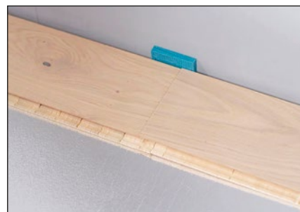
Utilisez les cales d'épaisseur en plastique pour respecter un écart d'au moins 10 à 15 mm par rapport aux murs et aux objets fixes dans la pièce.
